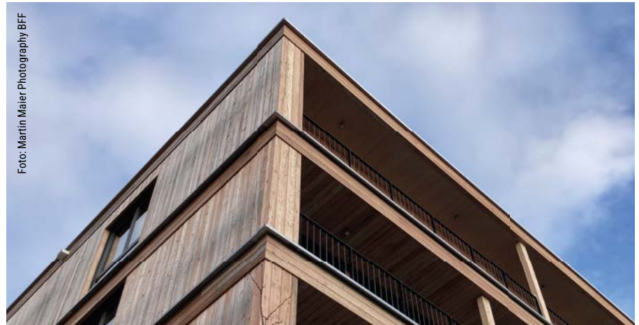
Die geschossweisen Brandschürzen, die es bei Holzfassaden gegen Brandüberschlag braucht, sind auch architektonisches Element und gliedern den Sechsgeschosser horizontal.
