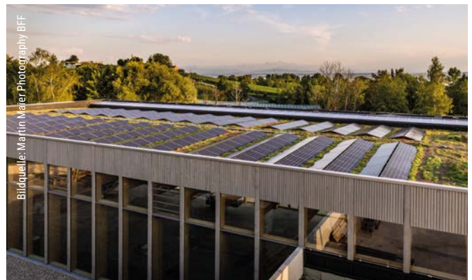
Das Dach der Fertigungshalle wurde als Gründach ausgeführt und mit einer 100-kW-Photovoltaik-Anlage ausgestattet.
