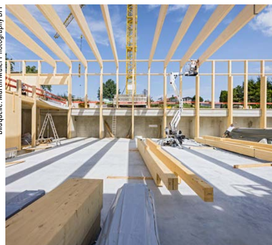
Im Achsabstand von 1,90 m spannen die Satteldach-Träger auf Stützen das Hallentragwerk auf. Im Hintergrund sind die Stahlbeton-Stützwände zu sehen.
