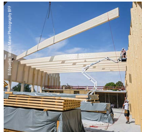
Die auf den Stützenköpfen aufgelegten Enden der Satteldach-Binder wurden zudem gegen Kippen in die Schlitze der BSP-Wand (links) eingeschoben.
