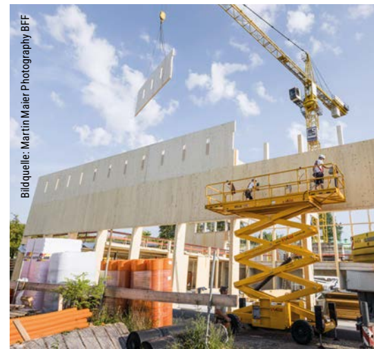
Montage des wandartigen Trägers aus 5-lagigem BSP bzw. der BSP-Elemente für die übrigen Wandbereiche über dem wandartigen Träger.
