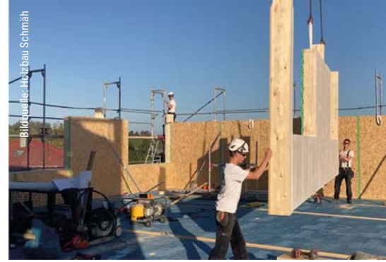
... hochwärmegeämmte Holztafelbau-Elemente geschossweise ausfachen.
