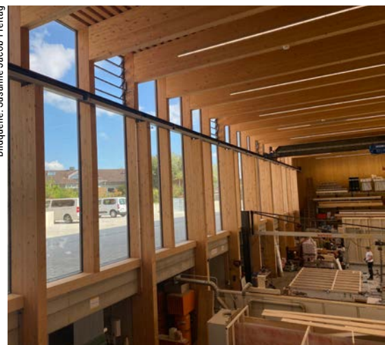
Die 20 cm breiten Stützen sind dort, wo die Kranbahn wie auf einer Konsole aufgelagert ist, „aufgedoppelt“, das heißt die Tiefe wurde von 24 cm auf 58 cm bzw. von 32 cm auf 68 cm vergrößert.
